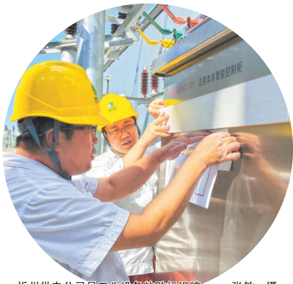
忻州供电公司员工为设备粘贴标识牌。
